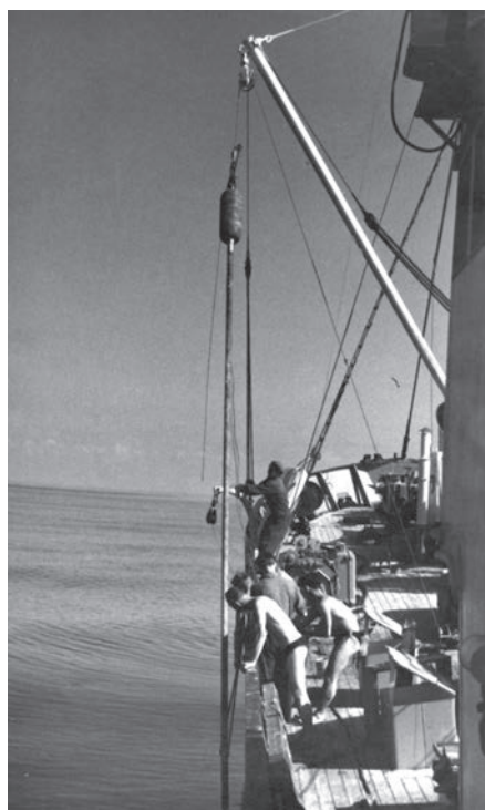
Спуск длинной поршневой трубки с борта НИС «Академик С. Вавилов» (1959 г. Средиземное море)
