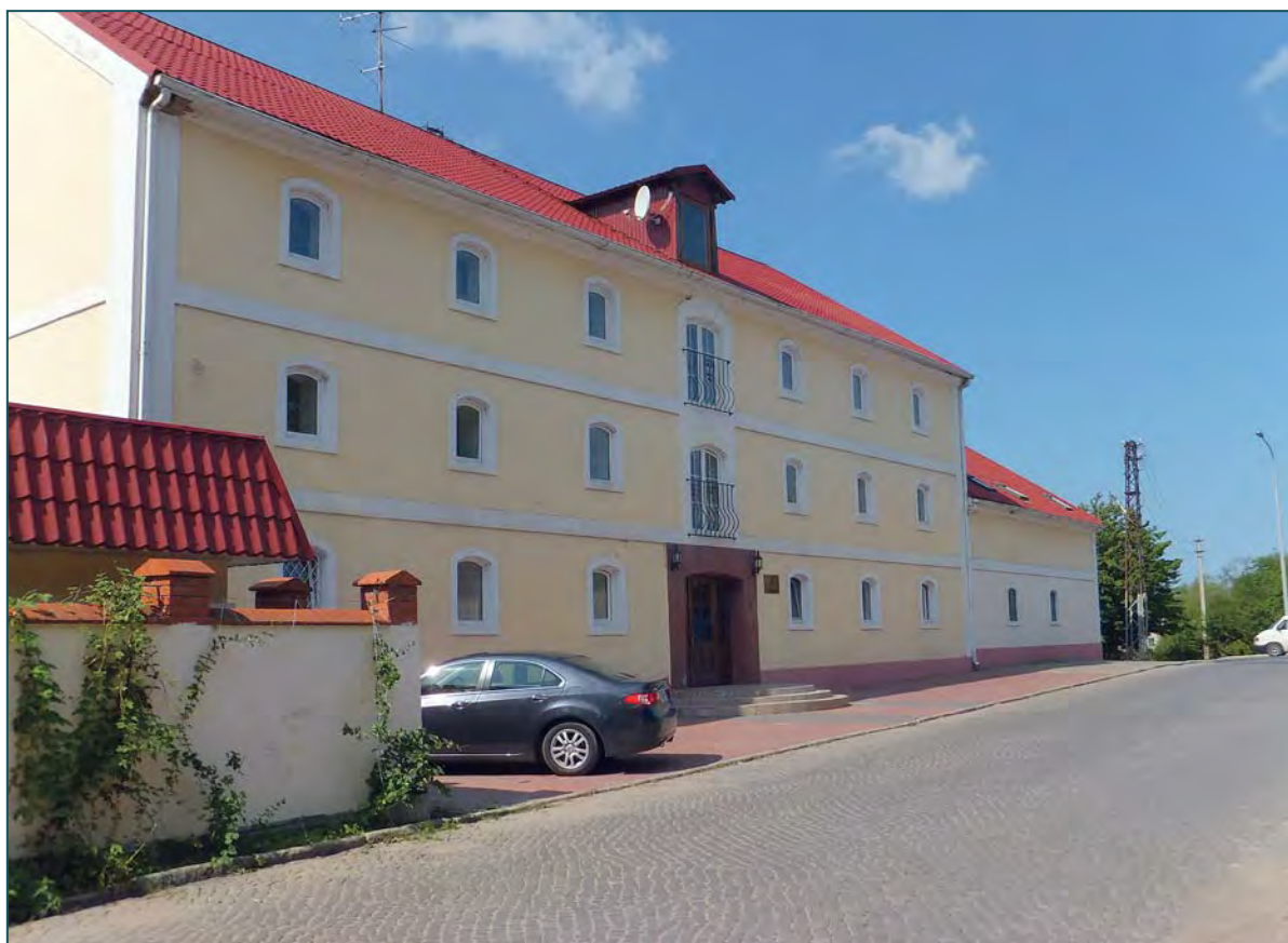
Рис. 27.1. Гостиница «У моста», г. Мамоново (фото Гусева В., 2013 г.)
